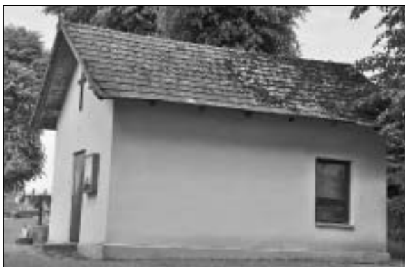
Budynek przed remontem
